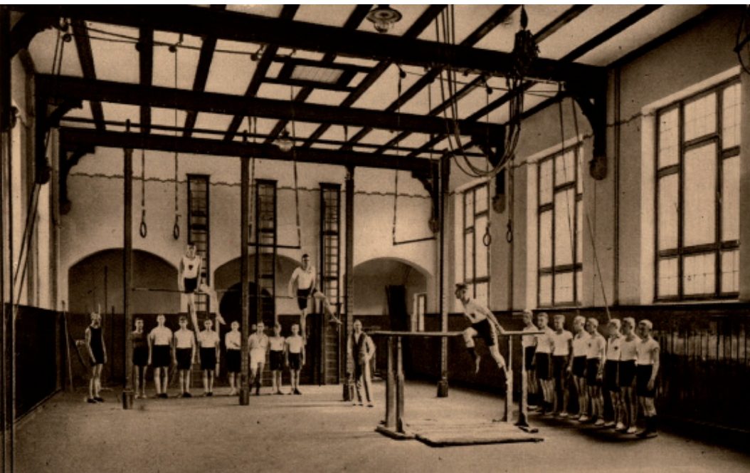
Schulsport in der ehemaligen Turnhalle
